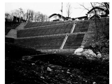
写真-3 復旧完了
