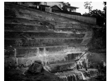
写真-2 鉄筋補強土
